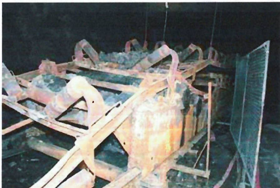
Figura 4 – Transportador de correia após o incêndio ( www.msha.gov )
